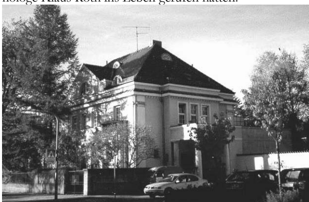
Abbildung 7: Das Haus in der Scheinerstraße
